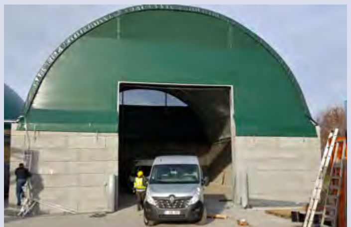
BiogasTec te Ardoioe
