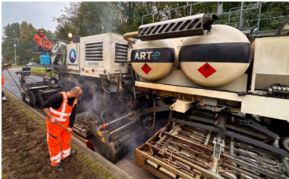
De Asphalt Recycling Train in actie.
