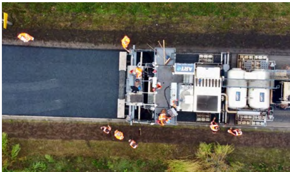
De Asphalt Recycling Train laat een strakke nieuwe weg achter als hij passeert.
