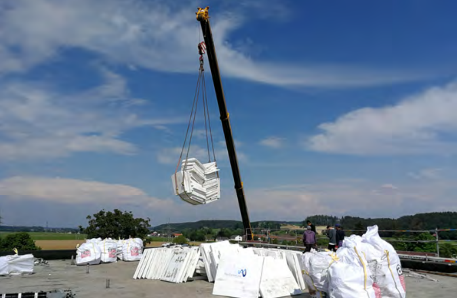
XPS-platen in afwachting van recycling.
