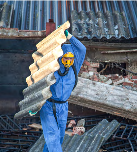
Sanering van asbesthoudende dakbedekking.
