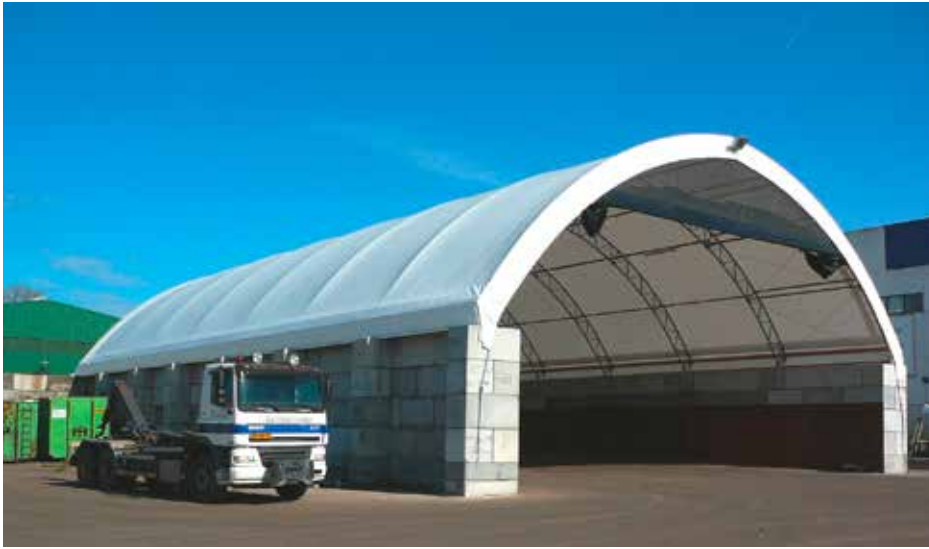
Overkapping op legioblokken bij De Meerlanden in Rijsenhout
