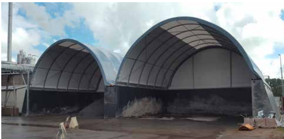
Overkappingen op stalen keerwanden bij Boskalis / HVC in Alkmaar.
