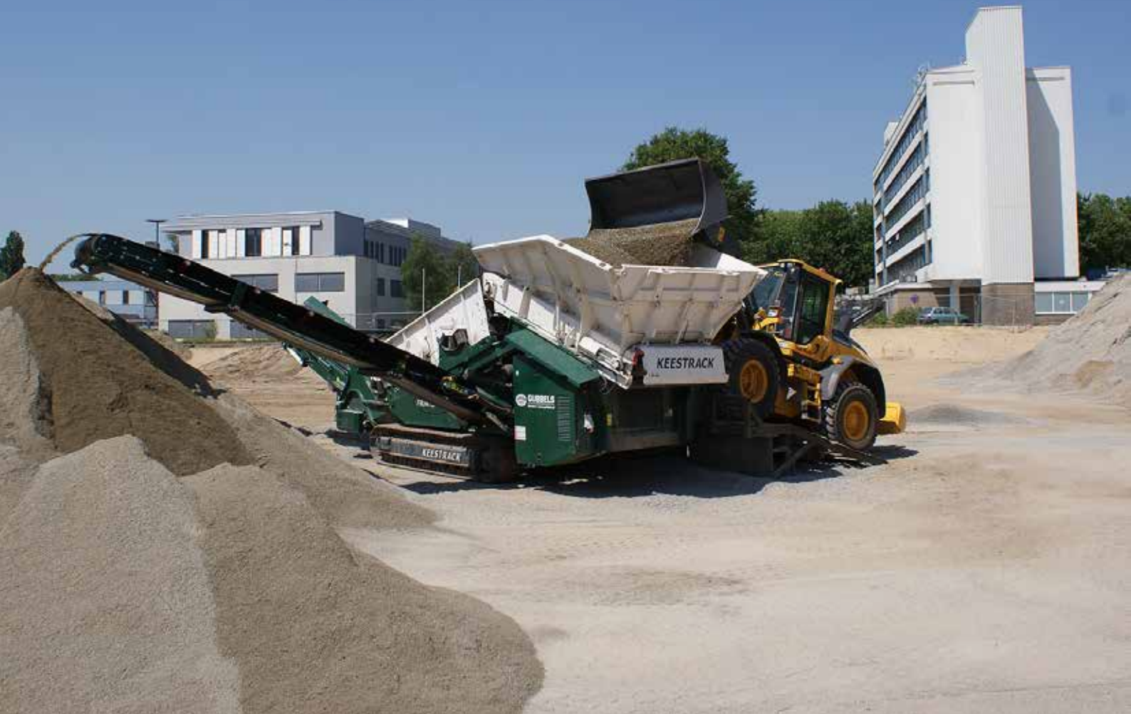
Productie van betongranulaat.
