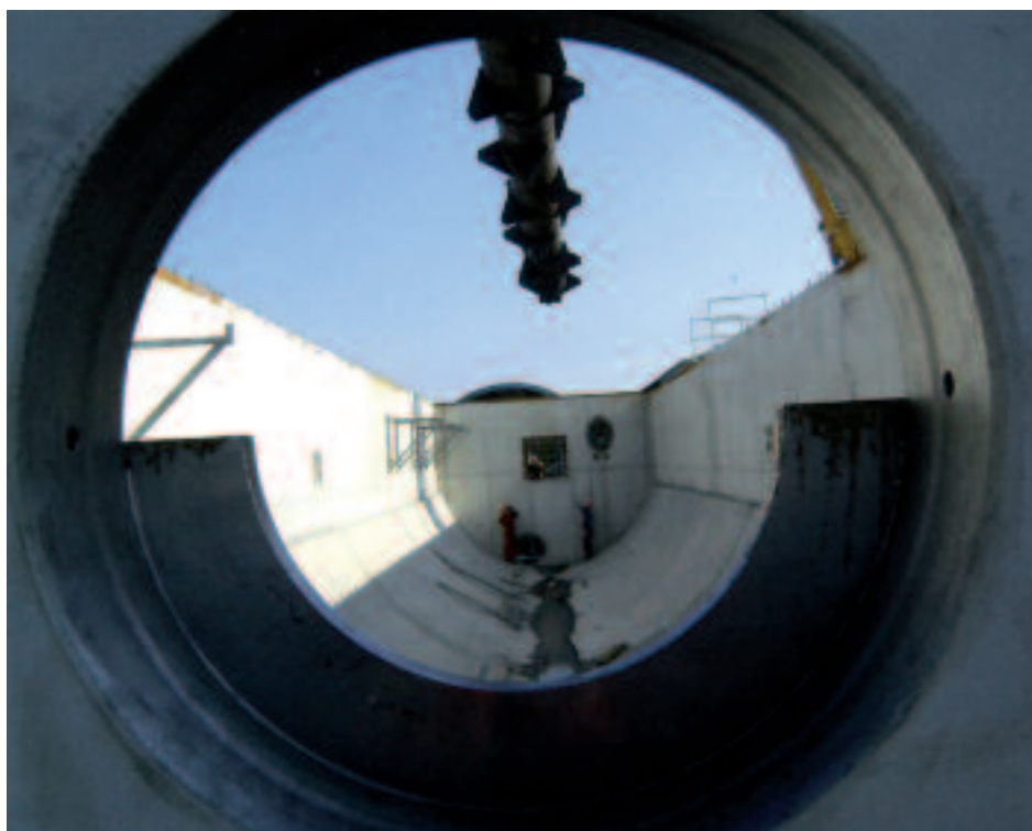
Bij de VAR in aanbouw zijnde composteerinstallatie.
