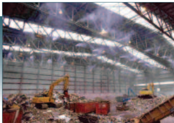
Stofbeperking met nevel voor hallen, bunkers, shredders/brekers en transportbanden
