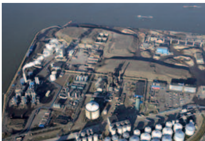
BRC's geavanceerde thermische reinigingsinstallaties op de Vondelingenplaat.
