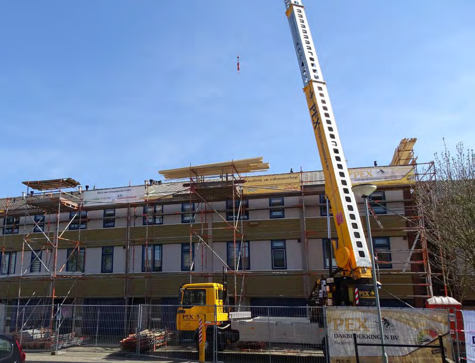
Het renovatieproject aan de Wagnerstraat in Venray.
