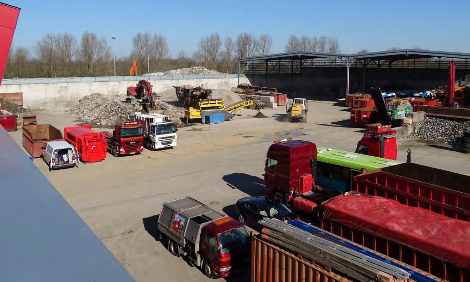
Onder de overkapping linksboven zal de nieuwe sorteerlijn worden gebouwd.
