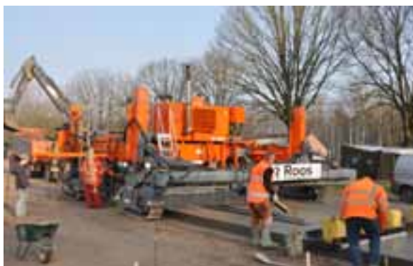
Ook de slipformpaver heeft geen moeite met het verwerken van recyclingbeton.
